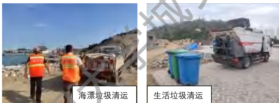
图5.5 施工期固体废物污染防治措施照片
