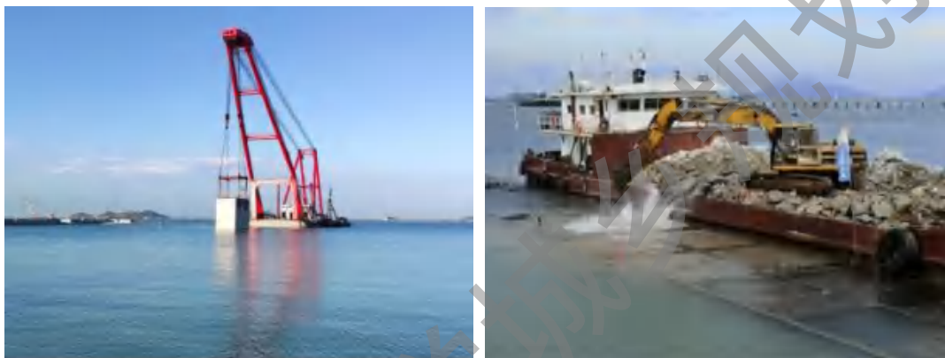
图 2.17 码头沉箱安装及沉箱填石施工场景图
