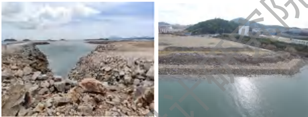
图 2.18 护岸施工场景图
